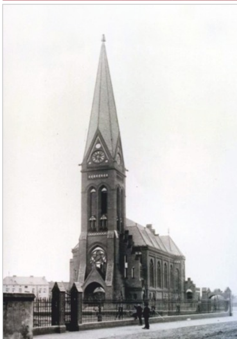
Kirche im ursprünglichen Zustand
